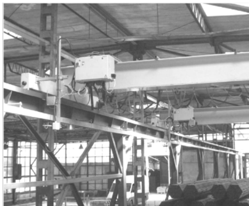
Слика 9-4. Кранска стаза је постављена на сопствену конструкцију
