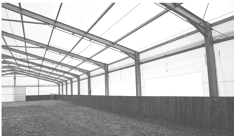
Слика 9-22. Провидни панои на крову хале
