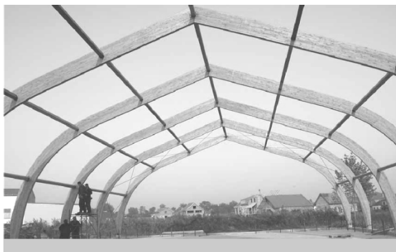
Слика 9-14. Хала од елемената лепљеног ламелираног дрвета ( L = 6 - 30 \text{ m} )
